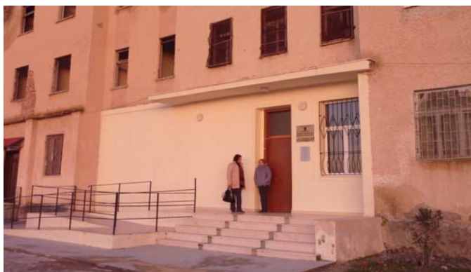
Bâtiment de Kuçova : la rampe permet l'accès avec les chaises roulantes
