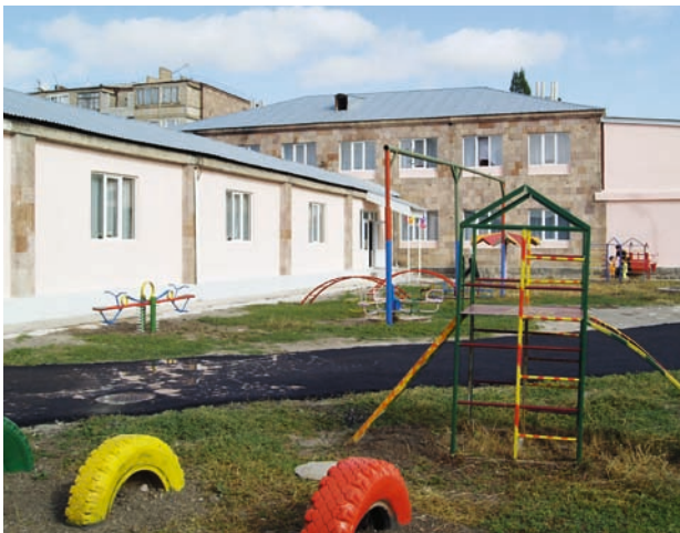
SEVAN ensemble des bâtiments rénovés par ASED
