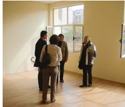
Kukës, travaux de rénovation pour la création du centre handicap - octobre 2008
