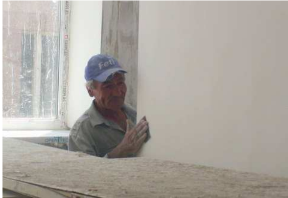
Réfection des enduits intérieurs du jardin d'enfants de Tsovaghyugh
