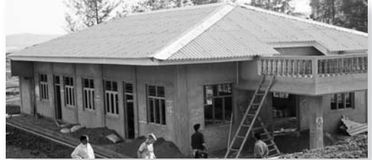
Inde: construction du Centre de Formation pour enseignants à Port Blair, Andaman
